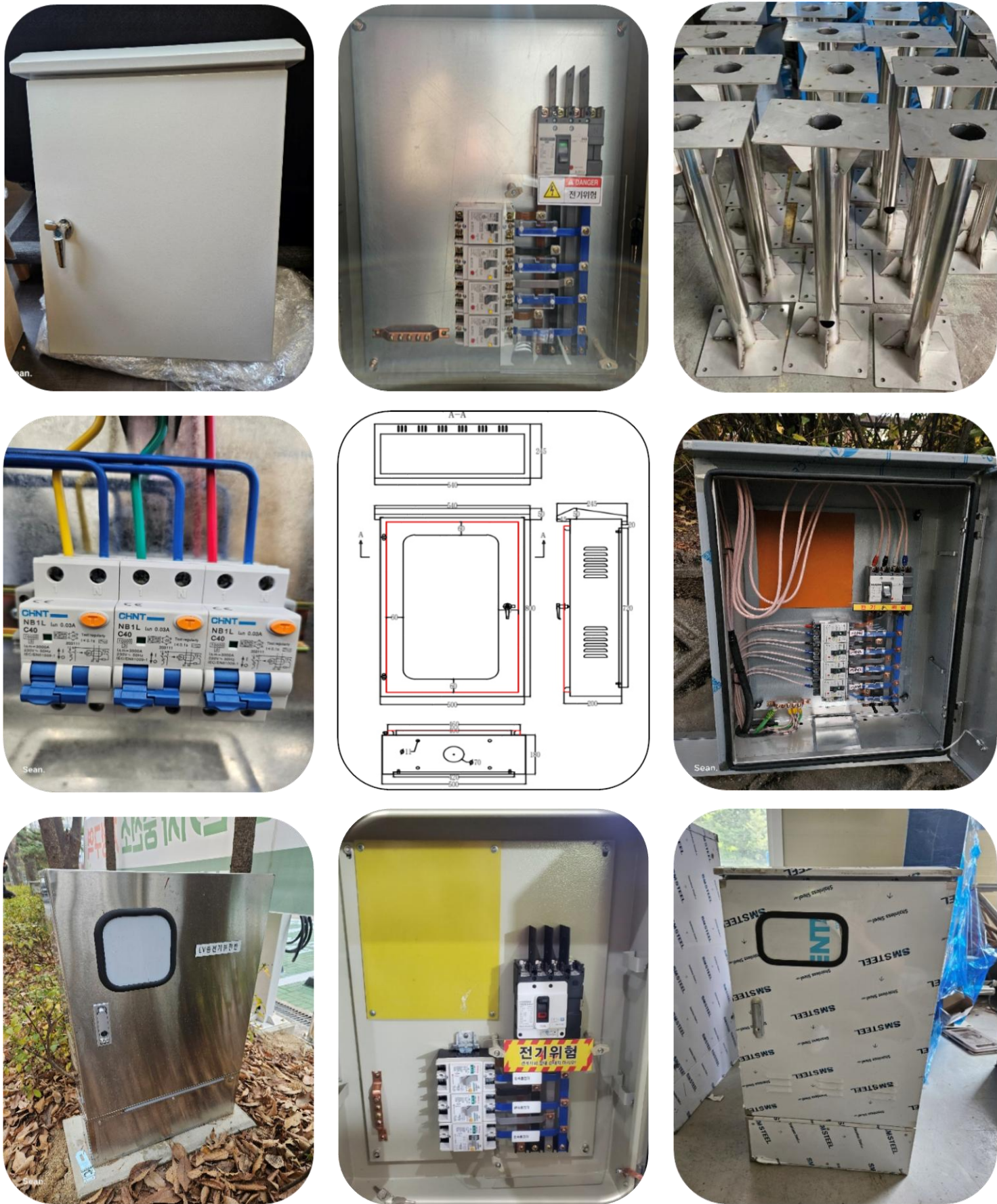
<2025 제품 및 현장 설치 사진>
